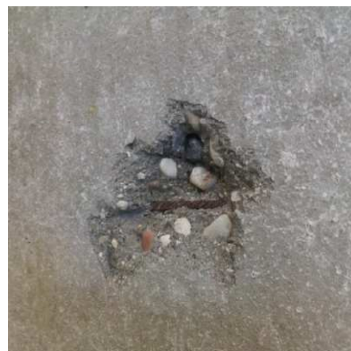
Fig.7: Staccamento del cls
