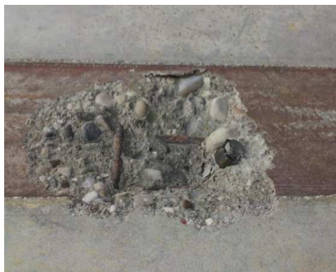
Fig.6: Rottura a taglio del connettore
